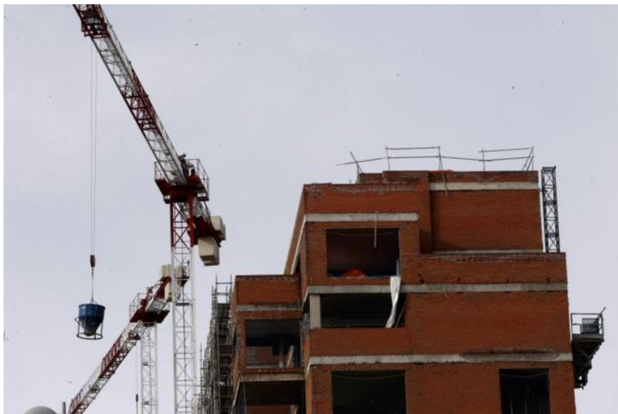
Imagen de grúas realizando labores de construcción de nuevas viviendas. | CARLOS BARAJAS
