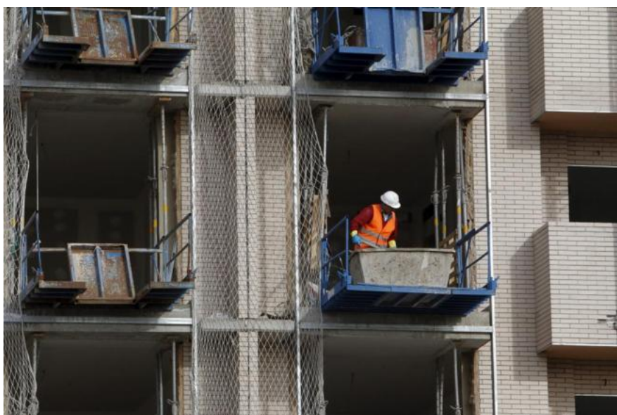
Imagen de la fachada de un edificio de viviendas en construcción. | CARLOS BARAJAS
